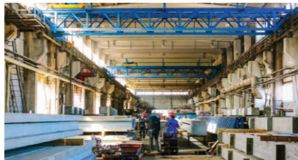
Завод ЖБК, пгт. Зеленовка, Самарская область
