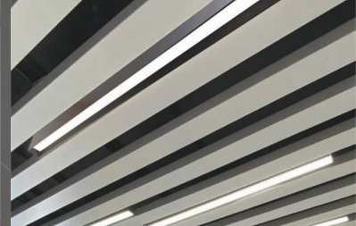
МОНТАЖ В ГРИЛЬЯТО
