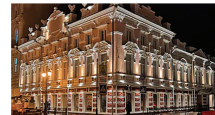
Здание театра, г. Астрахань
