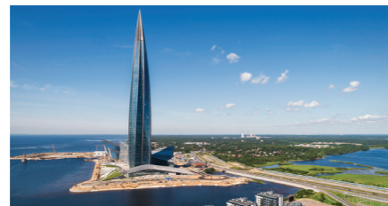
«Лакhta центр», г. Санкт-Петербург
