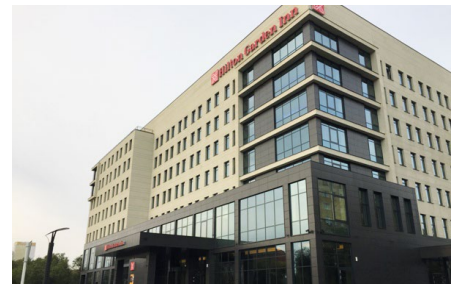
Гостиница HILTON GARDEN INN в г. Оренбурге Светильники эвакуационные ССА, светодиодные панели ДВО.
