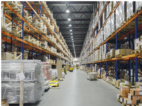
Склад: светильники для высоких пролетов ДСП
