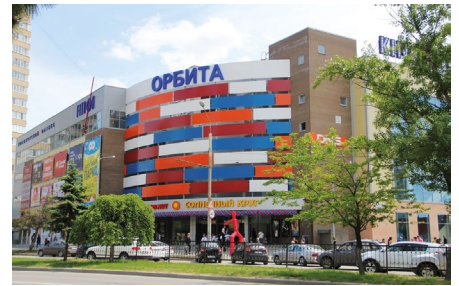
ТЦ «Орбита» в г. Ростове-на-Дону Светодиодные панели ДВО, прожекторы светодиодные СДО, блоки аварийного питания.
